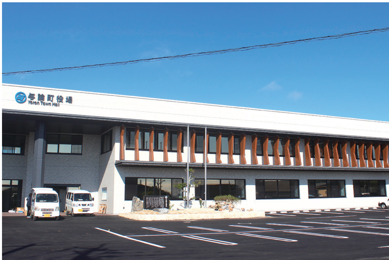
令和元年12月に完成した与論町役場新庁舎
